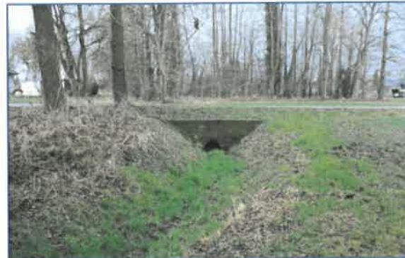
Abbildung 6.6: Durchlass unter der Straße „Flachswеiche“
