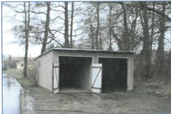
Abbildung 6.1: Garage im WA 2
