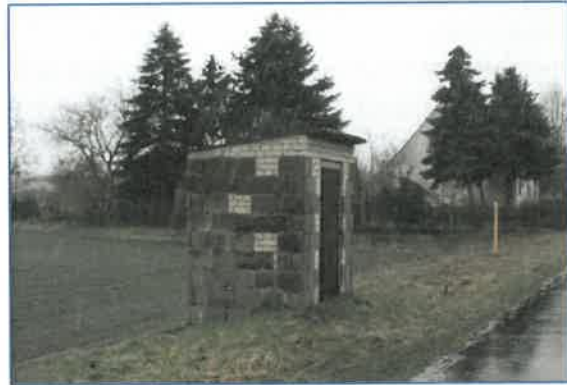
Abbildung 6.2: Kleines Gebäude im WA 2
